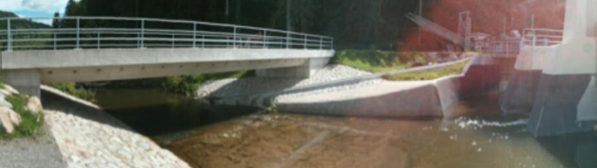
Im Panoramablick: Neu gebaute Zufahrt, der Makrozoobenthospass und das instandgesetzte Lauterwehr
